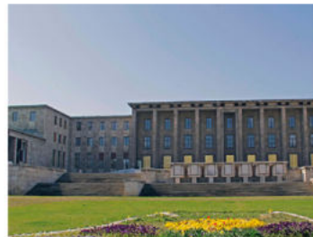
TBMM Enerji Odaları
